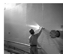
目視試験の様子
