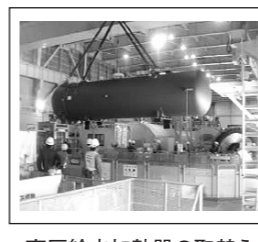
高圧給水加熱器の取替え
