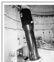
蒸気発生器の取替え
