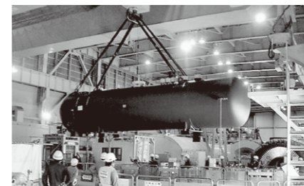
高圧給水加熱器取替えの様子
